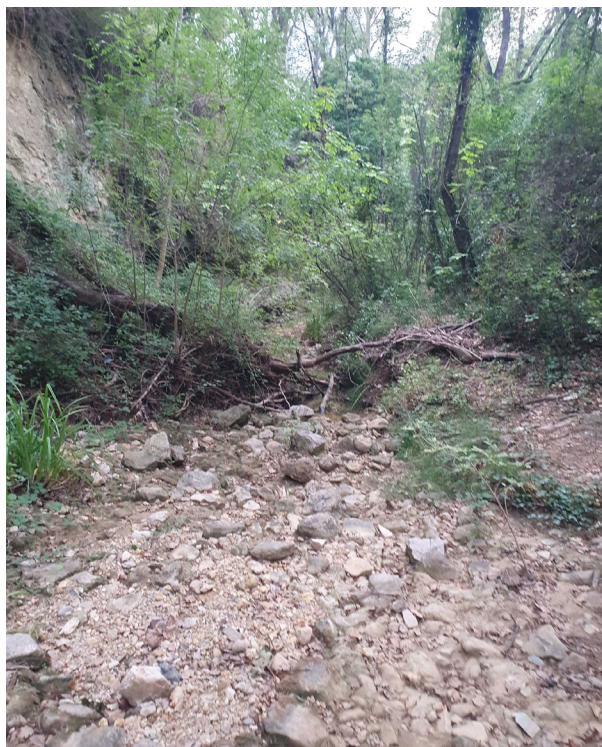
Figure 7. Assec en aval des seuils.
