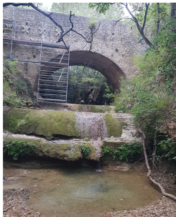
Figure 6. Seuil en aval du premier (visible en arrière-plan).
